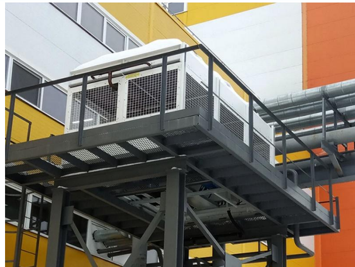
Чиллер NCT на предприятии по производству соусов «Жировой Комбинат»
