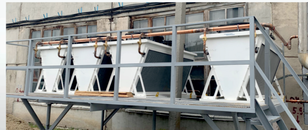
Алапаевский молочный завод. Свердловская область. Конденсаторы Q = 193 кВт. 2019 г. Установлено 8 конденсаторов для круглогодичного использования.
