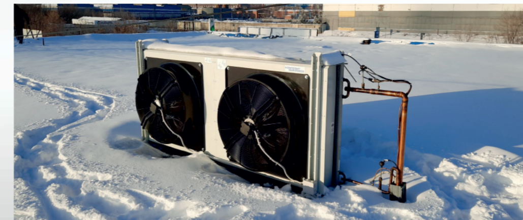
Испытательный стенд холодильного оборудования "Композит Микро" г. Екатеринбург. Конденсатор Q = 150 кВт. 2015 г. Круглогодичное использование.
