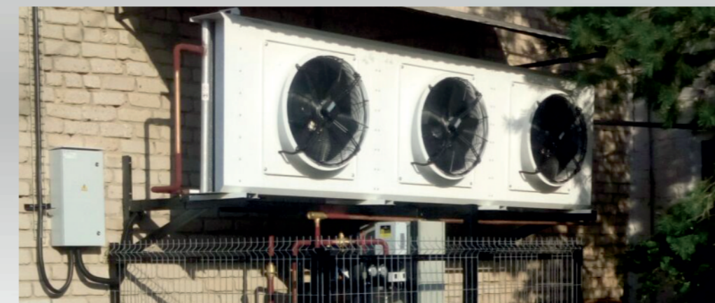
ФГКУ Комбинат "Девиз" Росрезерва, Удмуртская республика. Конденсатор Q = 132 кВт. 2016 г. Круглогодичное использование.
